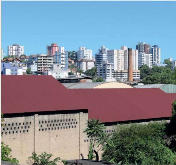
Reforma dos telhados da Unidade II
